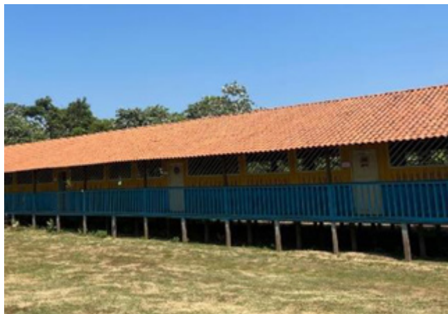
Figura 3. Escola do Pindurí apresenta o típico processo construtivo “palafitas”
